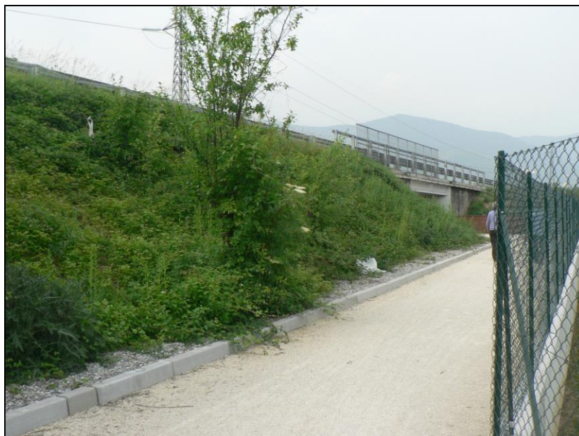
Figura 1 - Rilevato stradale che funge da ostacolo per eventuali fenomeni di trasporto in massa
