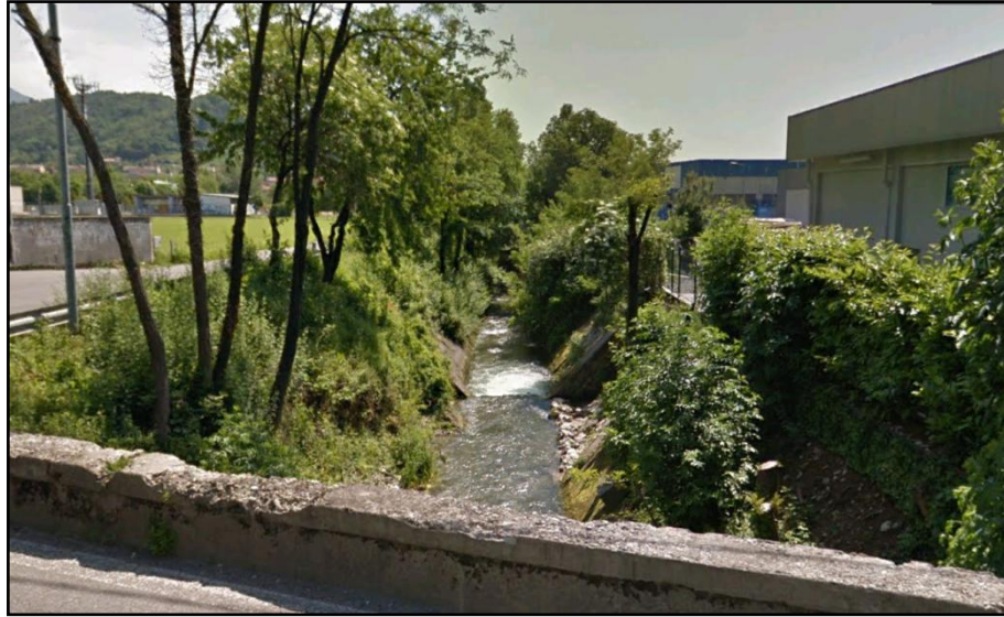
Figura 38 - Il Torrente Gardellone in corrispondenza del ponte di Via Viandasso
