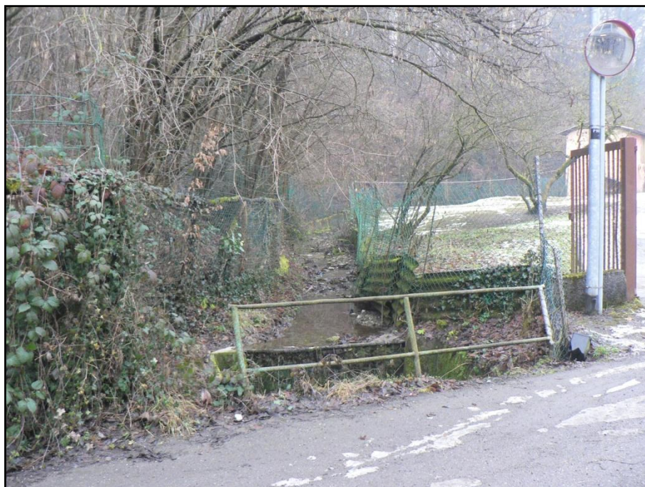
Figura 39 - Il Torrente Riolo nel punto in cui viene tombottato in Via Bergamina
