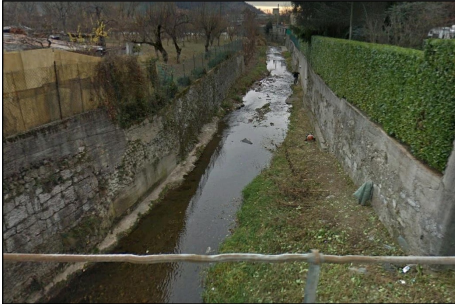
Figura 37 - Il Torrente Nesa all'altezza del ponte di Via Saleccia
