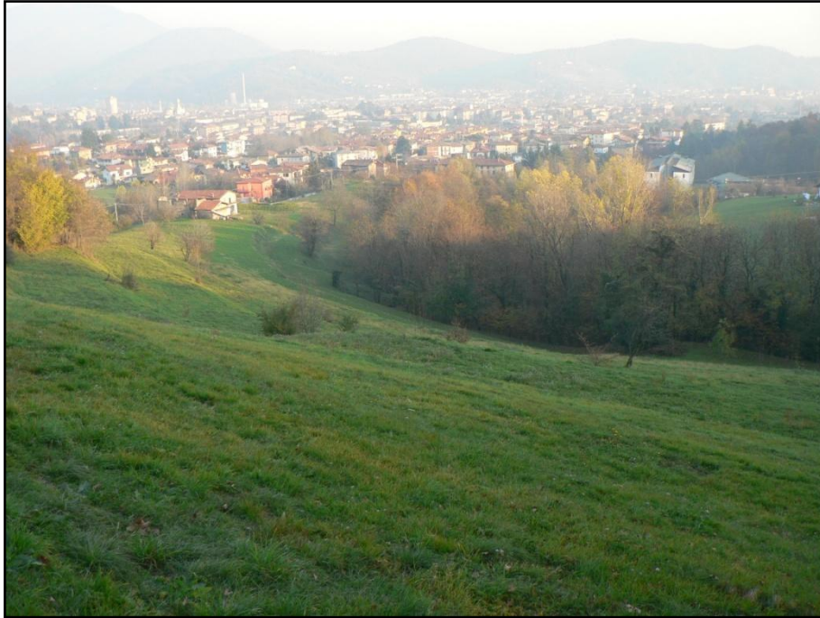
Figura 60 - Frana stabilizzata tra Cascina Bregn e Bergamina
