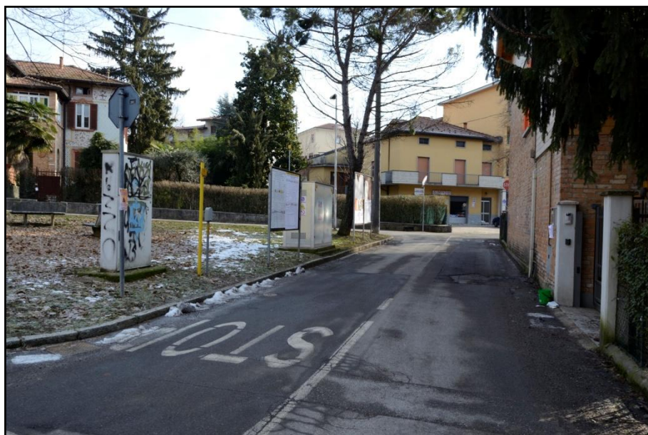
Figura 4 – L'incrocio stradale allagabile tra Via Bergamina, Via San Luigi, Via Zanino Colle, in direzione del negozio di alimentari di Via Trieste
