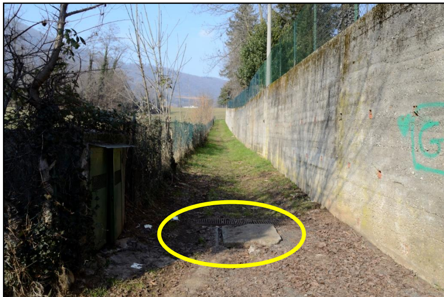
Figura 18 – Il tombotto ostruibile lungo Via Chignola Alta
