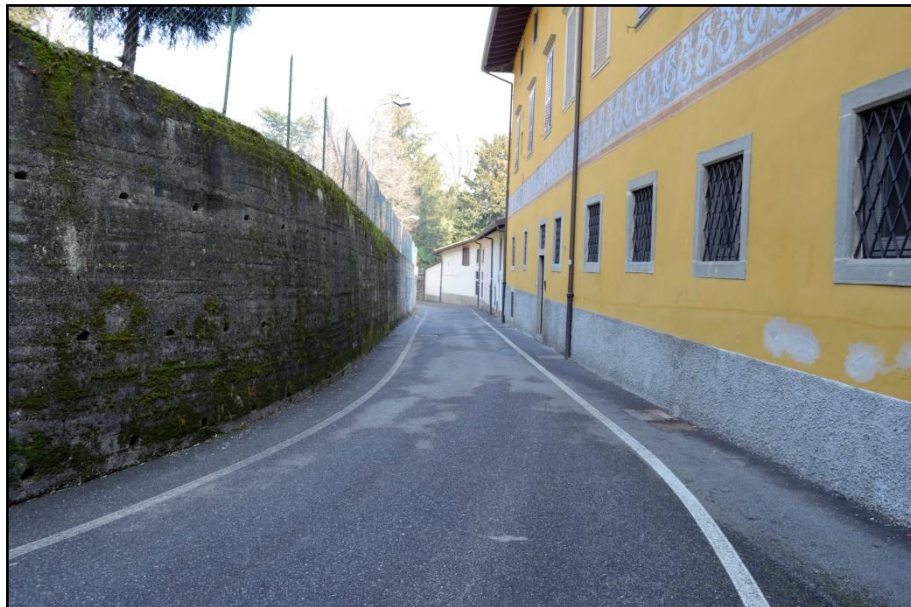
Figura 23 – Via Chignola Alta in direzione est; l’alto muraglione di monte e la parete senza interruzioni del nucleo storico rendono la strada praticamente un canale
