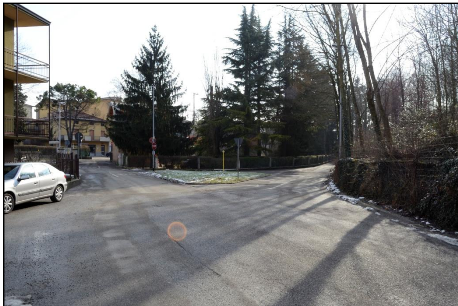
Figura 3 – L'incrocio stradale allagabile tra Via Bergamina, Via San Luigi, Via Zanino Colle
