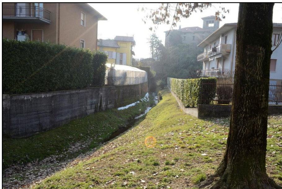
Figura 11 – Il Torrente Riolo nel punto ostruibile ad ovest di Via Riolo
