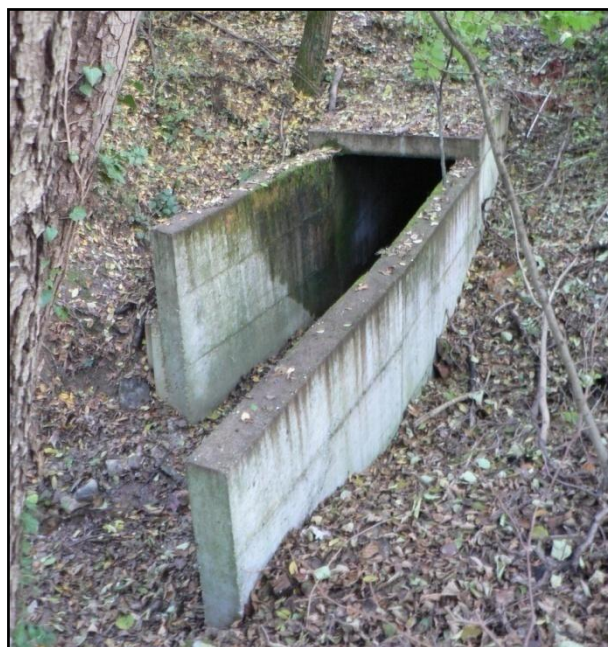
Figura 10 – L'imbocco del tombotto di Fornaci
