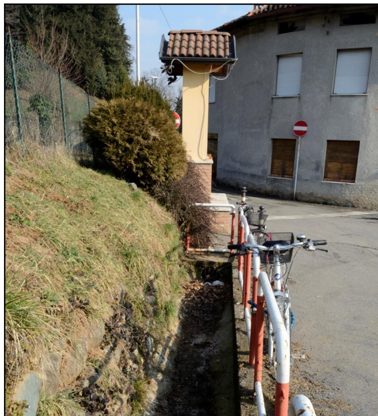
Figura 19 – Il tombotto ostruibile all'incrocio tra Via Chignola Alta e Via Brugale
