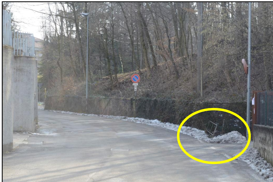
Figura 2 - Via Bergamina – punto di fuoriuscita dell'acqua in caso di ostruzione del tombotto del Torrente Riolo
